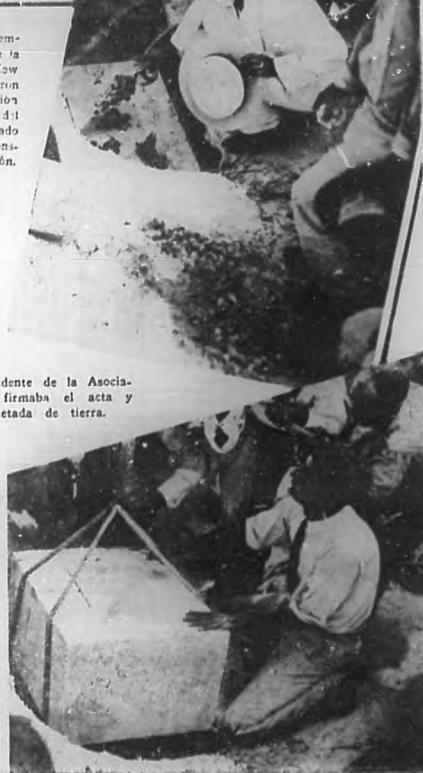
A los acordes del Himno Nacional en colocada la primera piedra del edificio.
